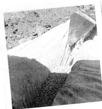
Exemple de tranchée d'infiltration
